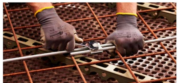
**9** Verbinden Sie im Nachgang die Rundstähle verzinkt Pos. 2 alle 2 m bzw. jede Stange 1x mithilfe der Bewehrungsklemme Pos. 9 mit der Bewehrung (M10 - SW 17 - 20 Nm).
