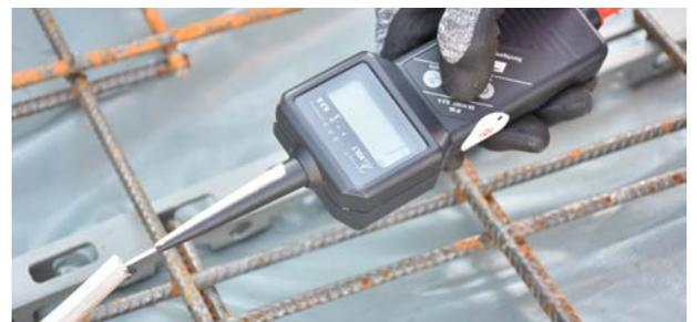
**13** Sollten bei einer Messung der Widerstand von 1 Ohm überschritten werden, überprüfen Sie alle entsprechenden Verbindungsstellen.
