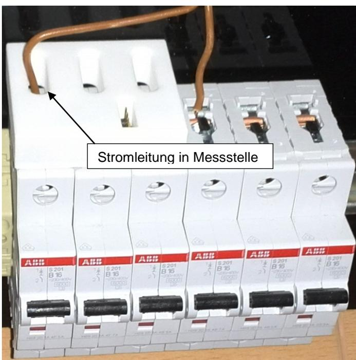
Die Stromleitungen werden durch die Öffnungen der Messstellen geführt und wieder angeschlossen.
