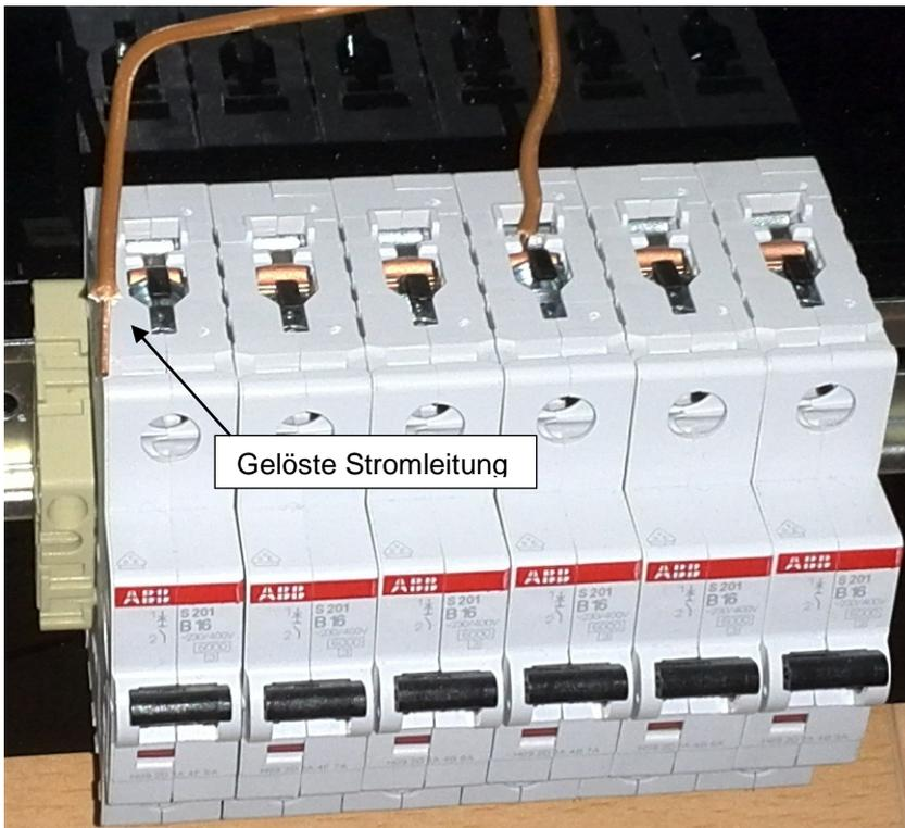
Vor der Befestigung der Sensoren müssen eventuell vorhandene Stromleitungen gelöst werden. Vor dem Arbeiten an diesen Leitungen sind diese stromlos zu schalten.
