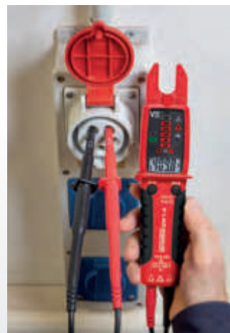
Spannungsmessung und Drehfeldrichtungsprüfung
