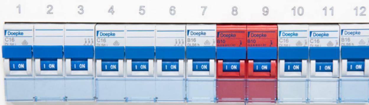
**Sofort im Blick** Unsere „roten“ Leitungsschutzschalter Nach der DIN VDE 0100-560 (Einrichtungen für Sicherheitszwecke) müssen Schalt- und Steuergeräte eindeutig gekennzeichnet sein. Dieses findet Anwendung in Endstromkreisen für z. B.
