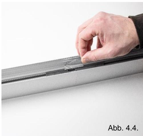
Zum Abschluss die Lichtdichtigkeitsfolie von innen auf die Profilvernähung der beiden Leuchtenprofile kleben.
