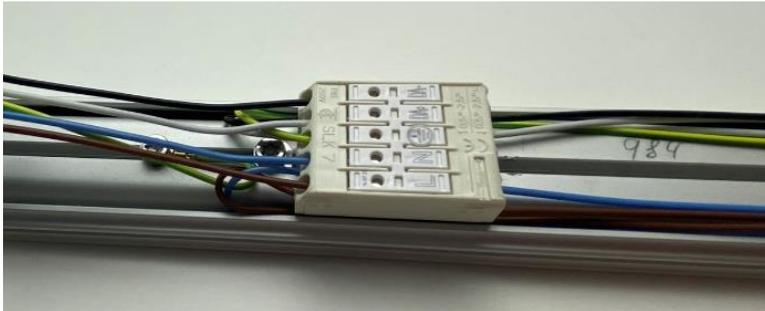
Zur Durchverdrahtung die Leuchteneinsätze mit Hilfe der Stecker und Kupplungen durchverdrahten.
