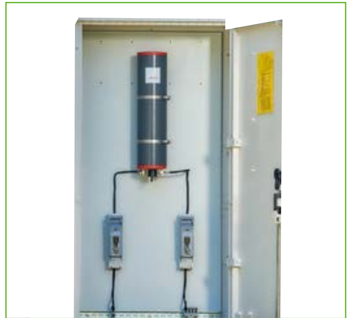
Fig. 4 Montage im Verteilerschrank
