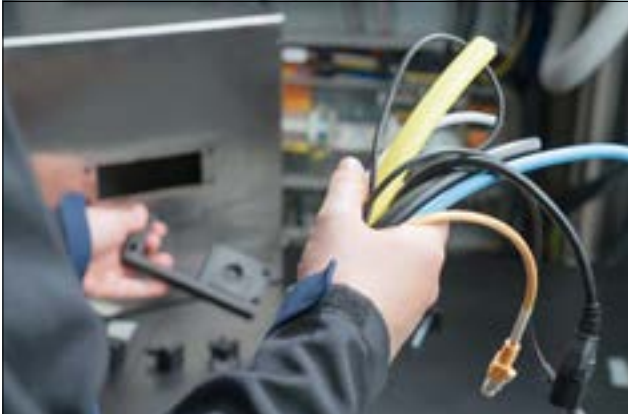
Wie verlegen Sie unterschiedlich große Kabel und dichten sie ab?
