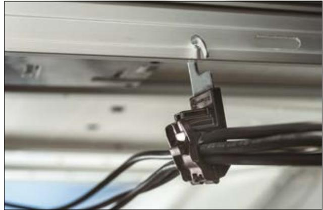
Ratchet P-Clamp montiert an einem Solarpanel.
