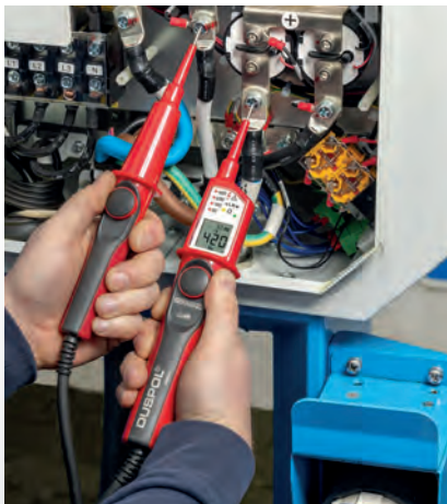
Contrôle de la tension de sortie d'un station de charge DC
