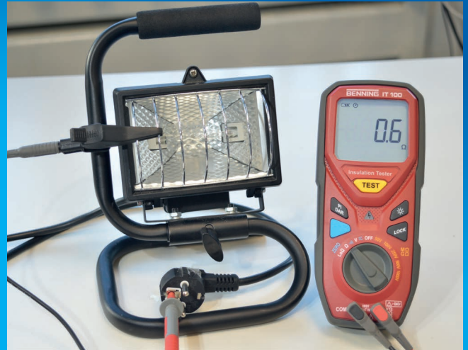
Widerstandsmessung zur Prüfung des Schutzleiters
