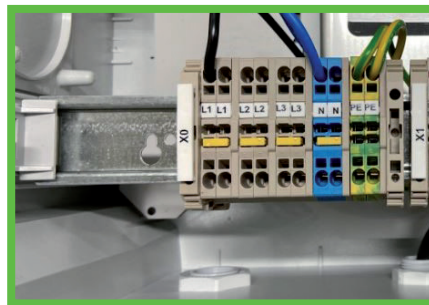
Fig. 14 A : Raccord 230V PURE
