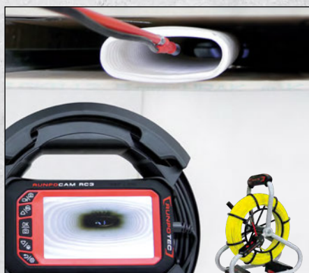
Lüftungs- und Wartungsinspektion
