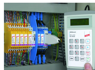
LifeCheck-Sensor mit Aufrastfunktion
