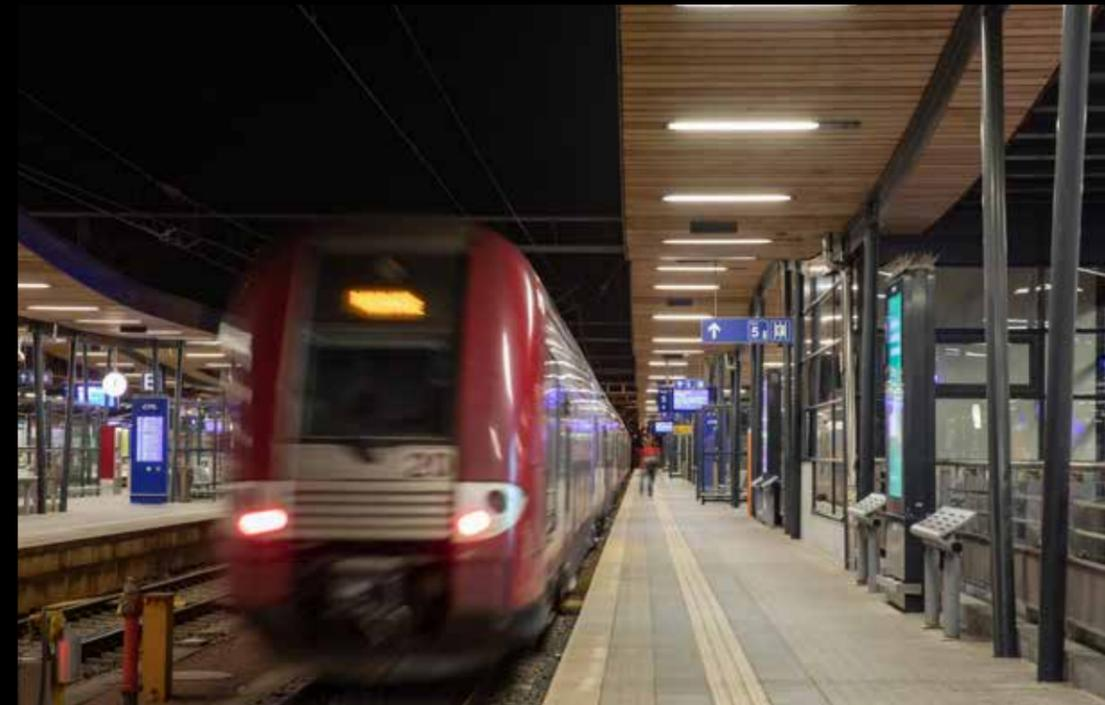
Bahnsteig mit PATMOS Sonderleuchten in Holzdecken montiert in vorgefertigter Aussparung.
