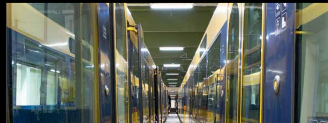
Die Leuchten sind durch die hohe Schutzart IP65 (APOLLO G2) und IP66/68/X9K (TUBIS LED INDUSTRY) sind die Leuchten gegen Staub und Nässe geschützt.
