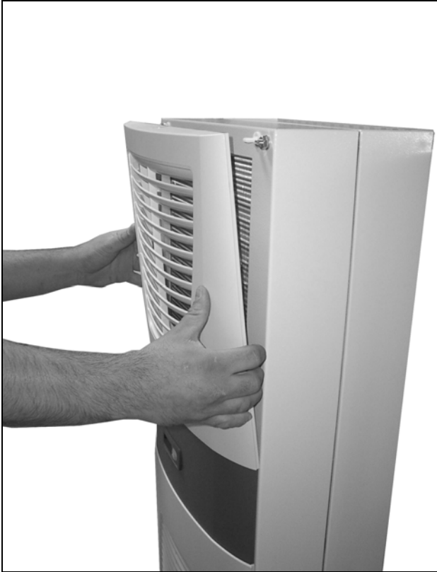
Abb. 35: Oberes Lamellengitter entfernen
