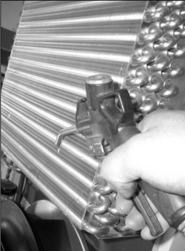
Abb. 51: Wärmetauschregister und Kompressorraum mit Druckluft ausblasen (1)
