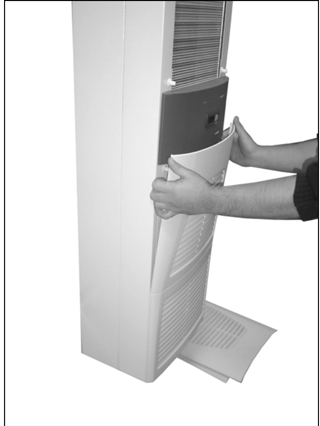
Abb. 57: Unteres Lamellengitter entfernen (1)
