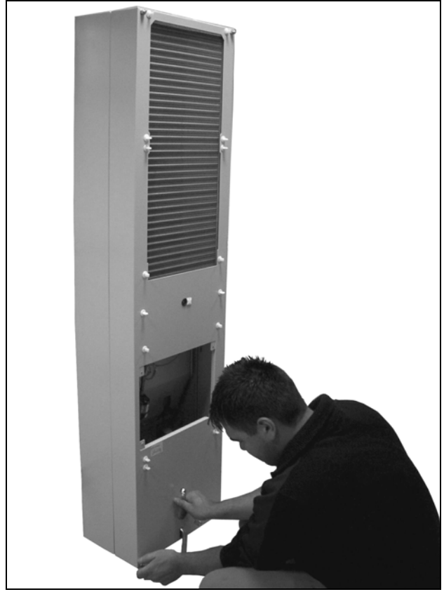
Abb. 70: Vier Muttern der Haube lösen
