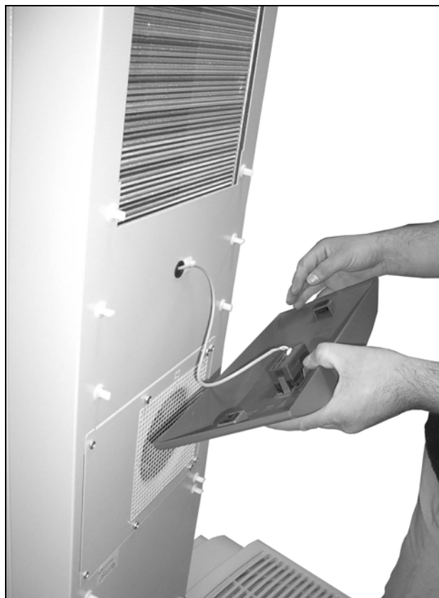
Obr. 59: Demontáž čelného modulu
