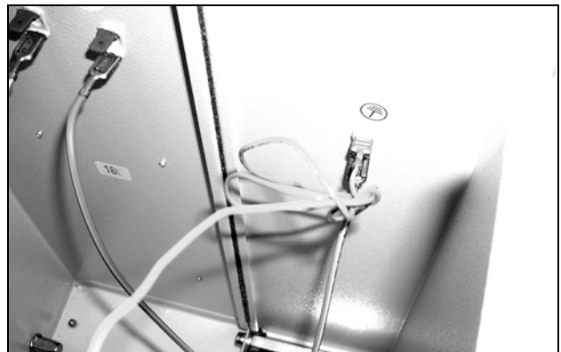
Obr. 68: Odpojenie zemniaceho kábla ventilátora (1)
