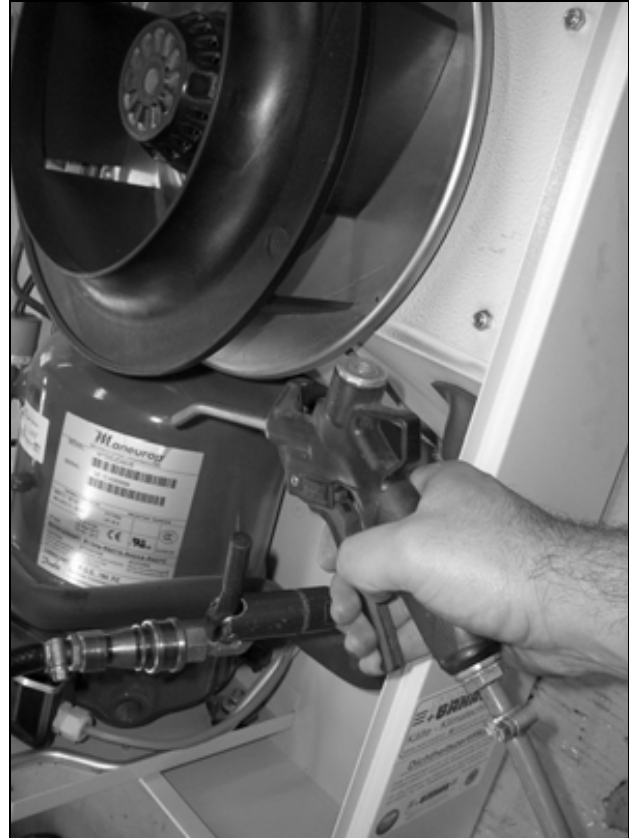
Obr. 76: Vyfúkanie telesa výmenníka tepla a priestoru kompresora stlačeným vzduchom (3)
