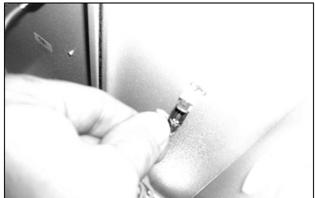
Obr. 69: Odpojenie zemniaceho kábla ventilátora (2)
