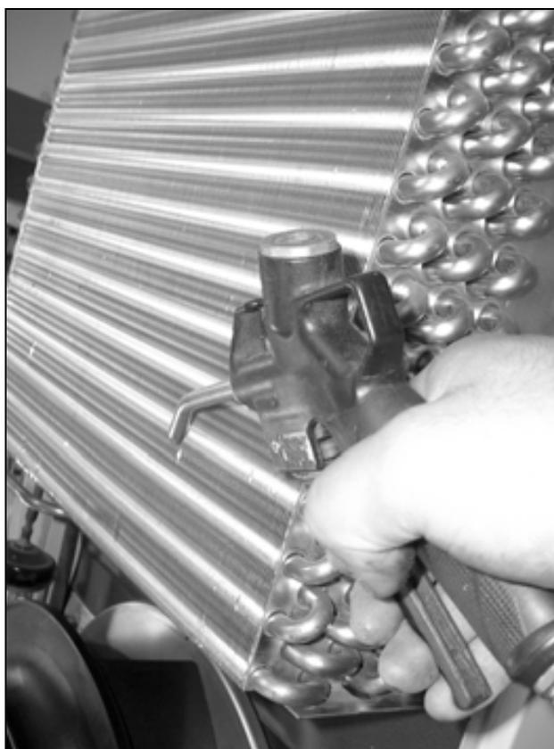
Fig. 56: Soffiare aria compressa sui tubi dello scambiatore di calore e nel vano compressore (1)
