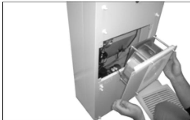
Fig. 69: Smontare il ventilatore del circuito esterno
