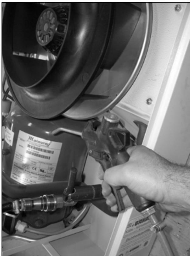
Fig. 57: Soffiare aria compressa sui tubi dello scambiatore di calore e nel vano compressore (2)
