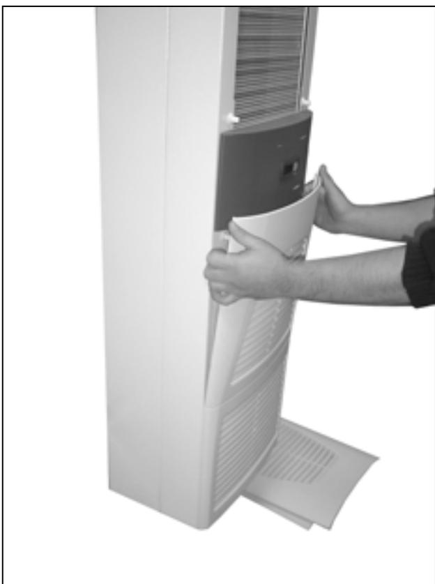
Fig. 62: Rimuovere la griglia di aerazione inferiore (1)
