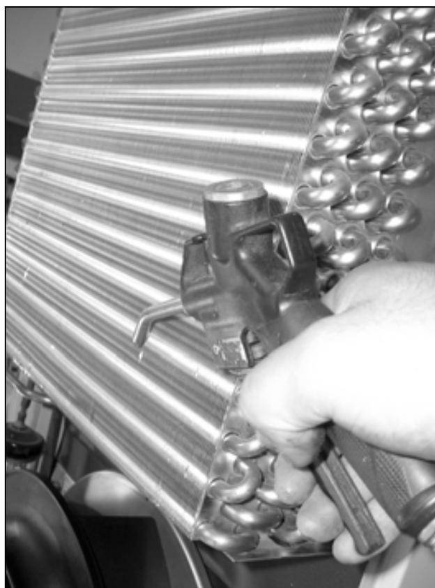
Imagen 56: Aplicar aire a presión en el registro del intercambiador de calor y el espacio del compresor (1)
