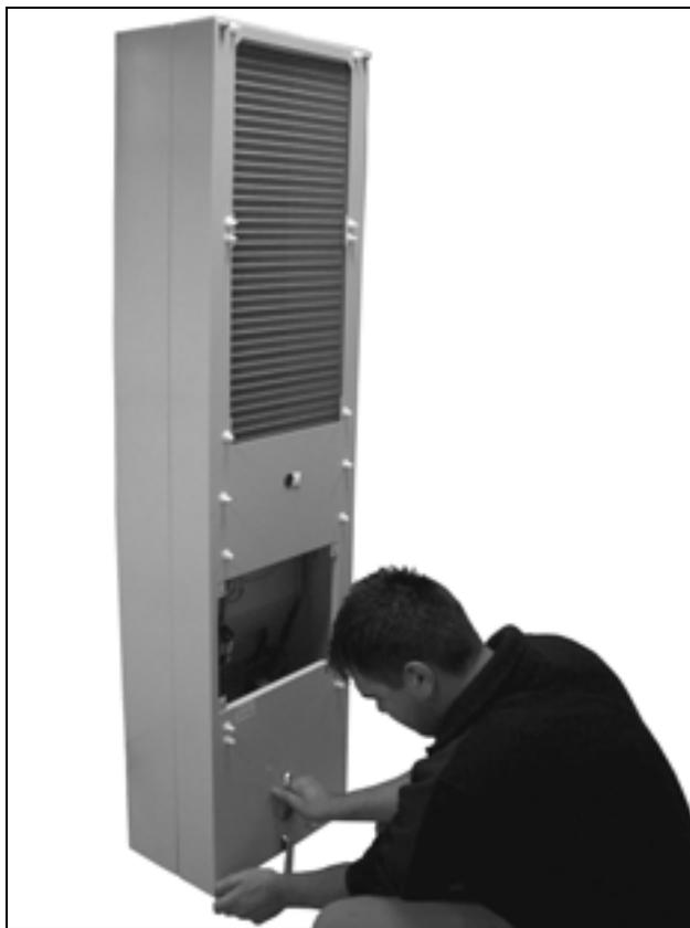
Imagen 75: Desenroscar las cuatro tuercas de la cubierta
