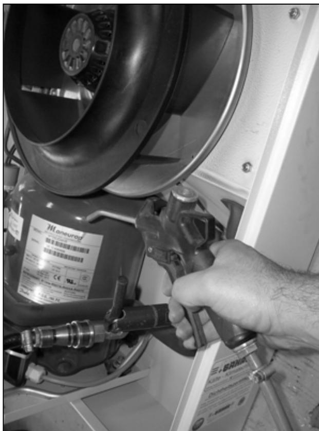
Imagen 81: Aplicar aire a presión en el registro del intercambiador de calor y el espacio del compresor (3)
