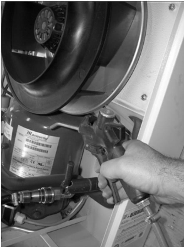
Imagen 57: Aplicar aire a presión en el registro del intercambiador de calor y el espacio del compresor (2)
