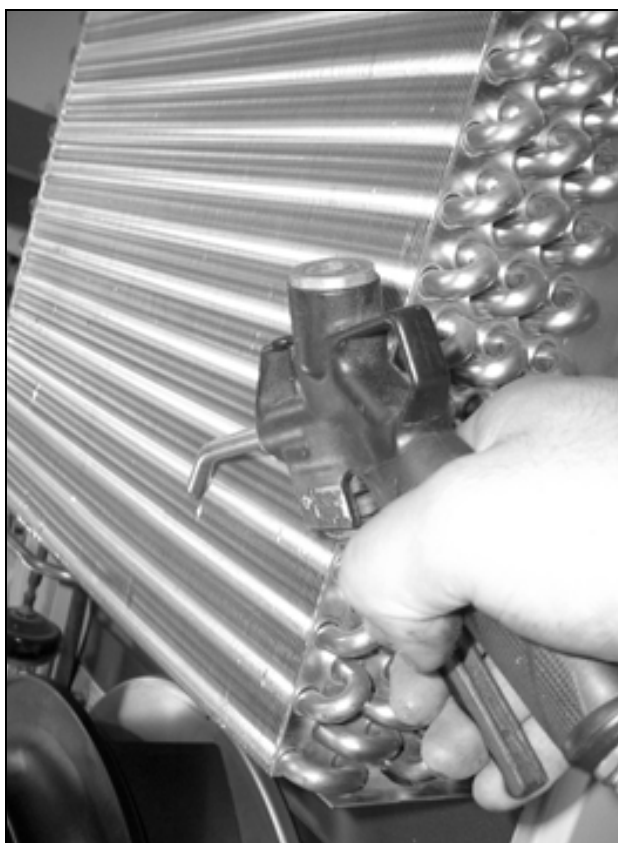
Fig. 56: Limpar os tubos do trocador de calor e o compartimento do compressor com ar comprimido (1)
