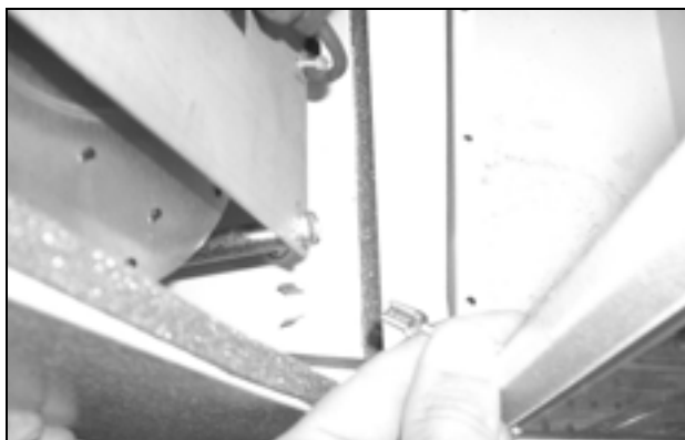
Fig. 55: Soltar o cabo de aterramento que se encontra entre a tampa e o chassi (2)
