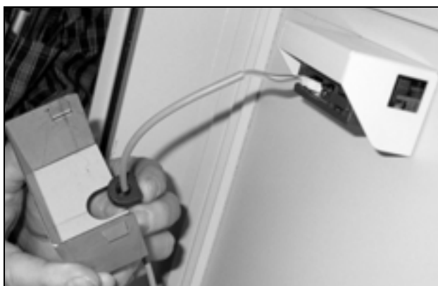
Fig. 16 : Insérer le joint passe-câble
