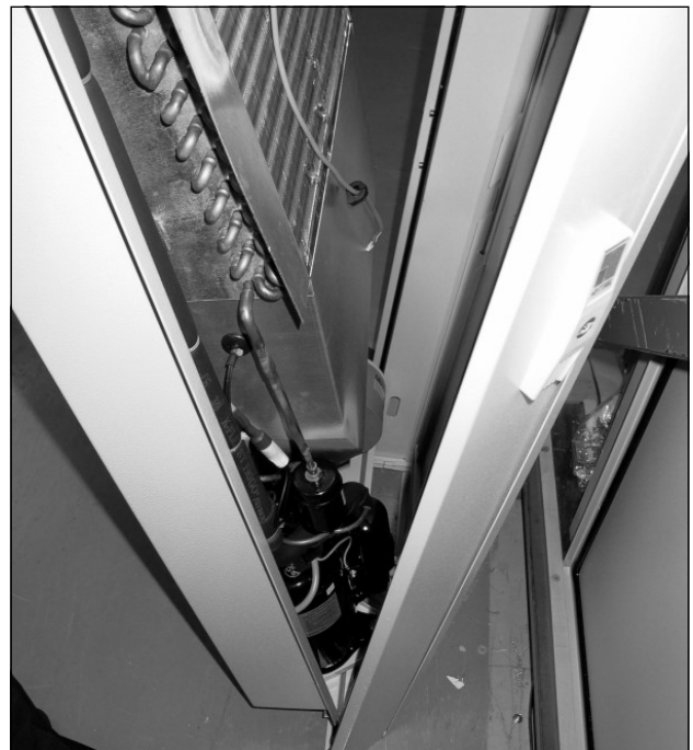
図 8: 空調ドアへの温度管理モジュールの取付け
