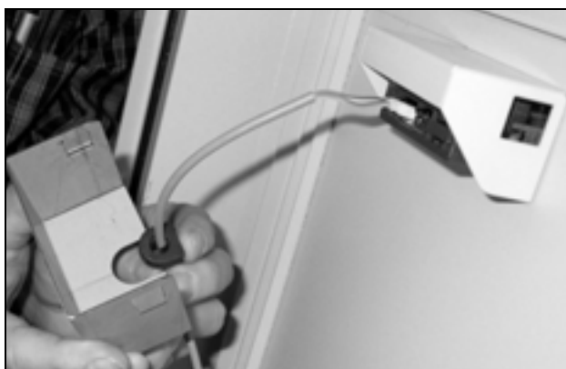
Fig. 16: Introduzione della guaina del cavo
