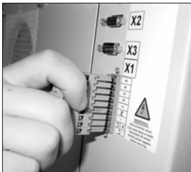
Fig. 28: Estrarre il connettore di alimentazione
