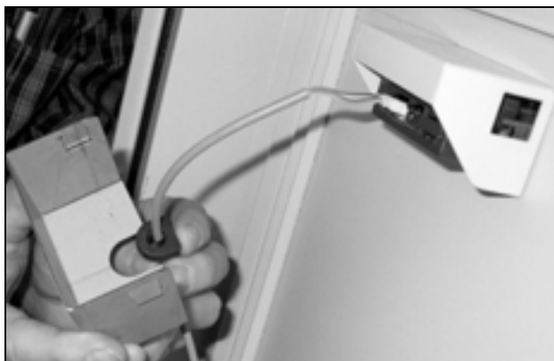
Imagen 16: Introducir la boquilla para cables
