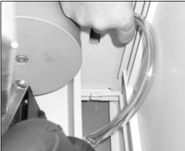
Bild 9: Kondensavloppet leds ut ur aggregatet
