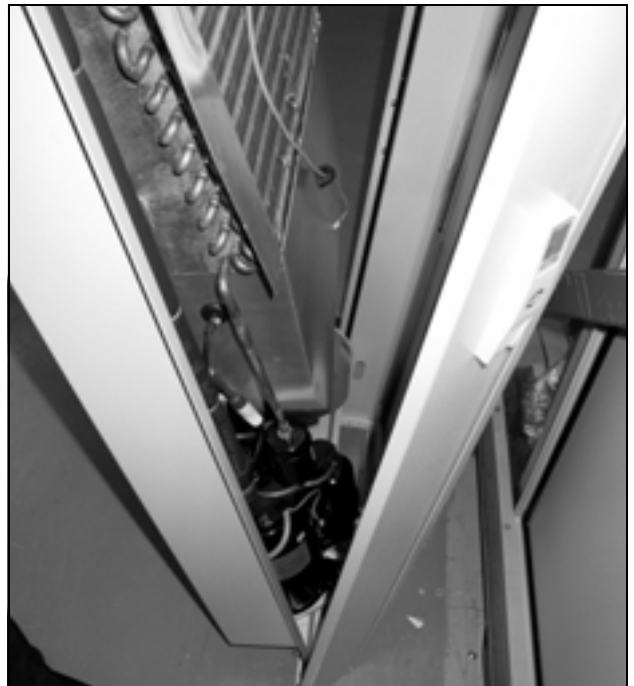
Bild 8: Montering av kylmodulen i profildörren
