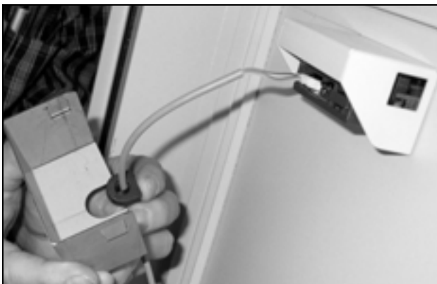
Bild 16: För in skyddsringen för kabeln
