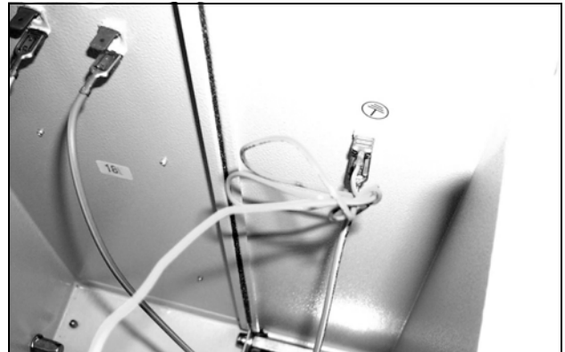
Fig. 68 : Retirer le câble de mise à la masse du ventilateur (1)
