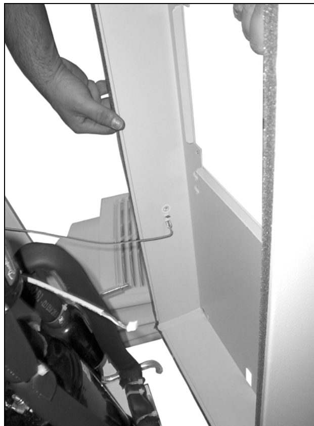
Fig. 72 : Retirer le câble de mise à la masse (1)
