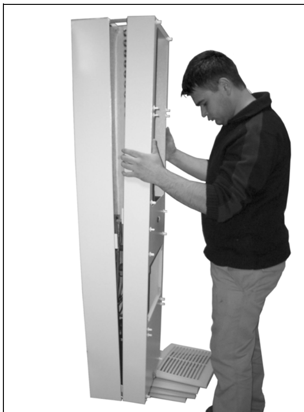
Fig. 71 : Retirer le capot
