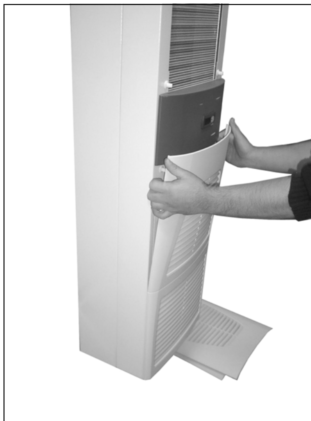
Fig. 57 : Retirer la grille à lamelles inférieure (1)
