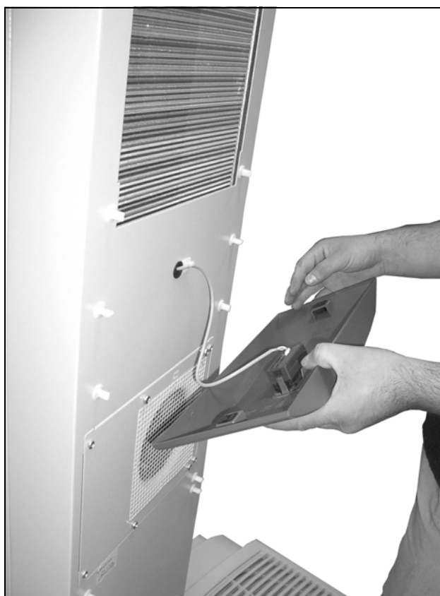
Fig. 59 : Retirer le plastron
