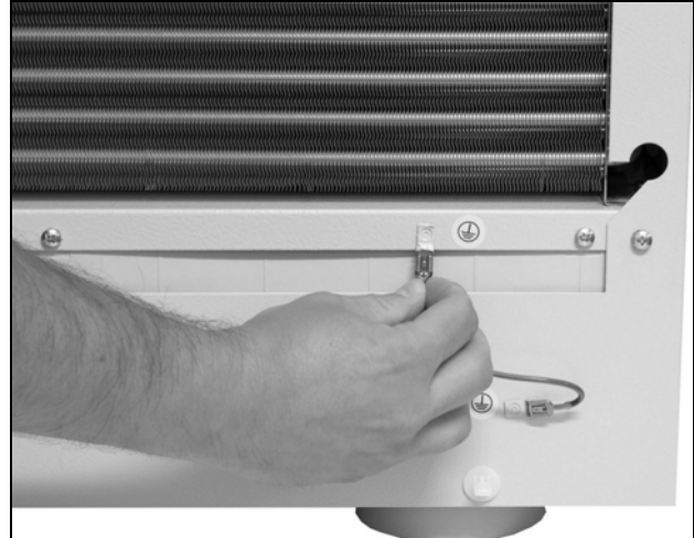
Abb. 25: Erdungskabel abziehen
