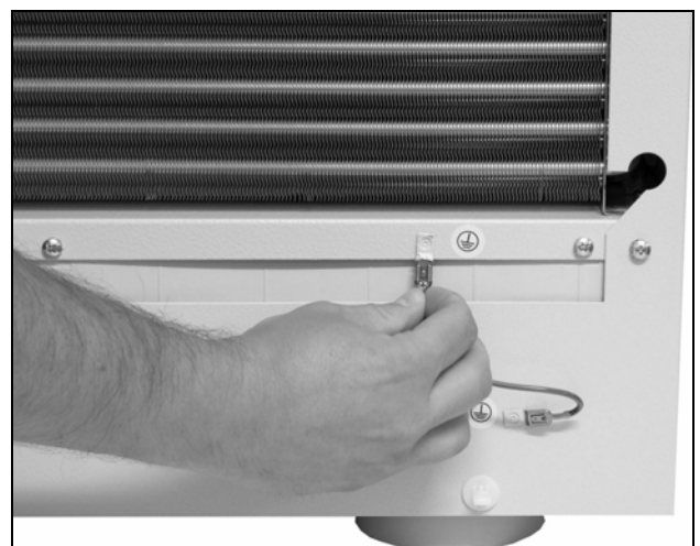
Fig. 25 : Ôter le câble de mise à la masse
