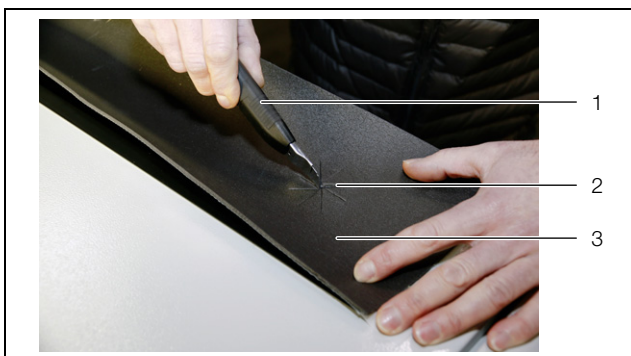
Abb. 6: Einbringen der Kabeldurchführung
