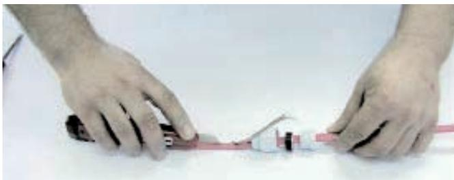
3. Schneiden Sie die Innenisolierung mittels Messer ca. 70 mm ab und entfernen sie.
