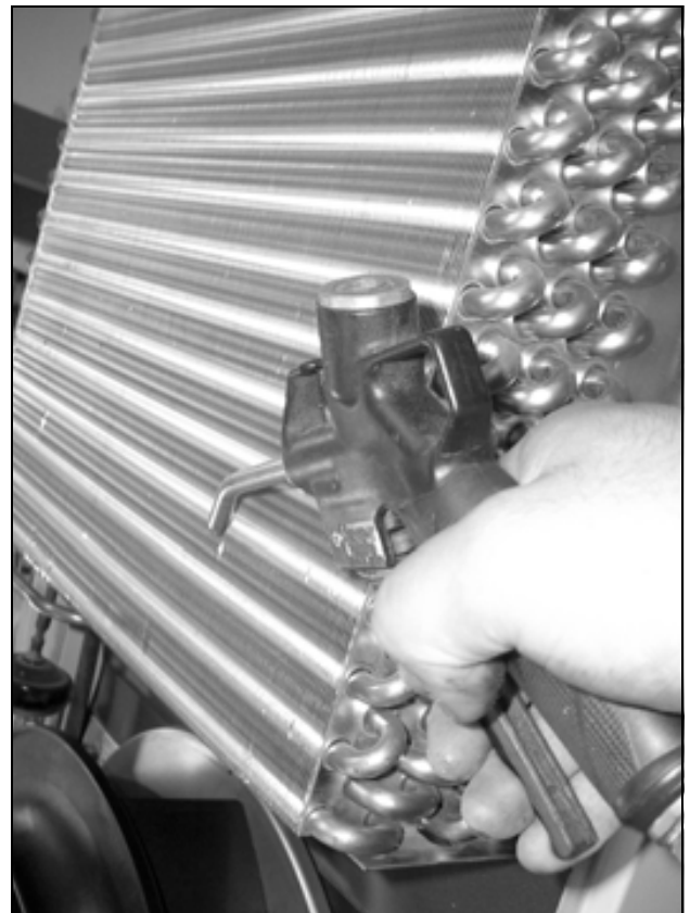
イラスト 75: 熱交換ユニット (凝縮器) および圧縮機領域を圧縮空気で吹き払う (2)
