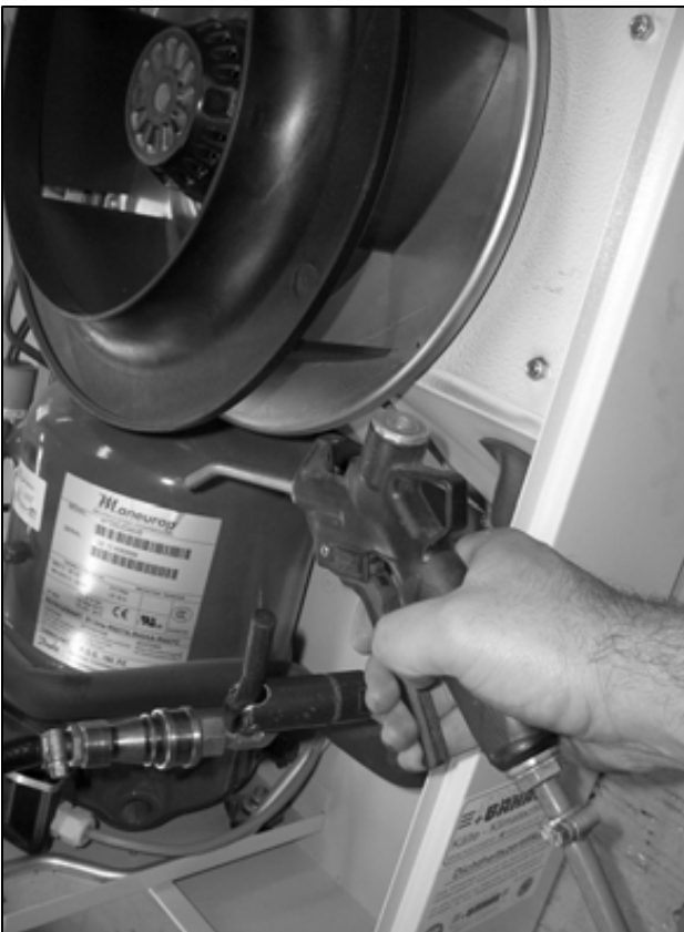
イラスト 52: 熱交換ユニット (凝縮器) および圧縮機領域を圧縮空気で吹き払う (2)
