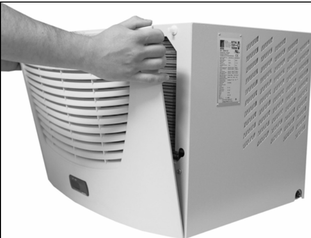
Imagen 22: Desmontar la rejilla
