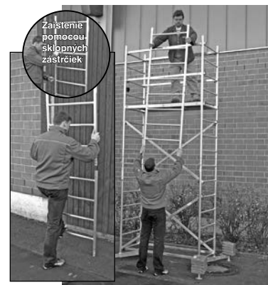
Základné lešenie s prvou a druhou nadstavbou
