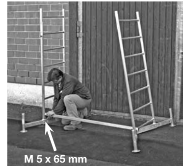
Grunnstillas med første tilbygg
