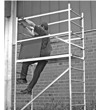
Grundgerüst mit erster Aufstockung
