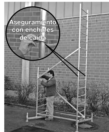
Andamio básico con primer piso
