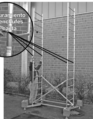
Andamio básico con primero y segundo piso
