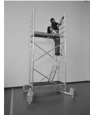
Grundställning med första och andra påbyggnaderna.
