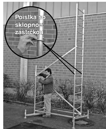
Základné lešenie s prvou nadstavbou
