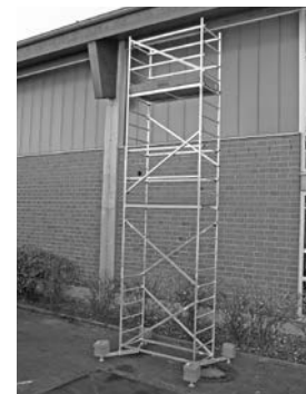
Basisplatform met eerste en tweede slag
