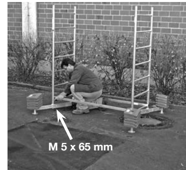
Grundmodul med første og anden tilbygning
