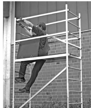
Základné lešenie s prvou nadstavbou
