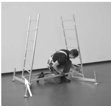
Grundställning med första påbyggnad
