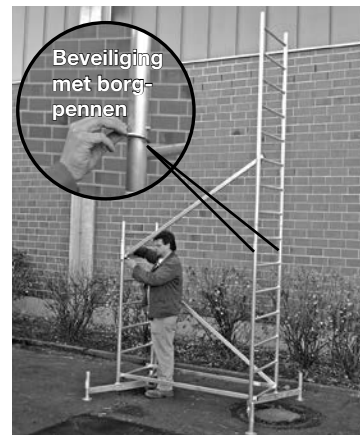
Basissteiger met eerste slag
