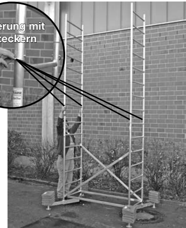
Grundgerüst mit erster und zweiter Aufstockung
