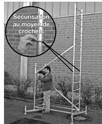
Échafaudage de base avec première rehausse
