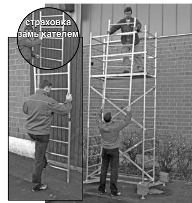
Базовая конструкция с первой и второй надстройками
