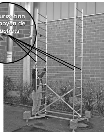
Échafaudage de base avec première et deuxième rehausses
