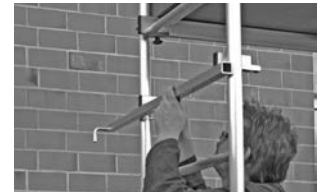
Perustelineet kahdella lisäkerroksella
