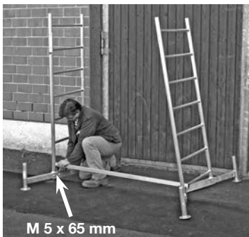
Échafaudage de base avec première rehausse
