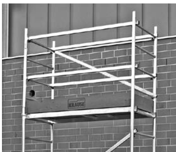
Základné lešenie s prvou nadstavbou
