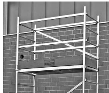
Grunnstillas med første tilbygg
