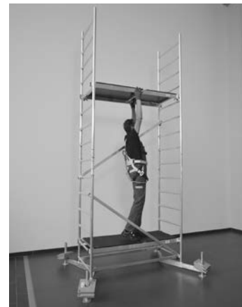
Grundställning med första påbyggnad
