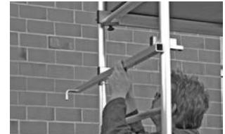
Perustelineet yhdellä lisäkerroksella
