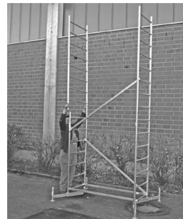
Grunnstillas med første tilbygg
