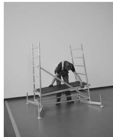
Grundställning med första påbyggnad
