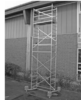
Grundgerüst mit erster und zweiter Aufstockung
