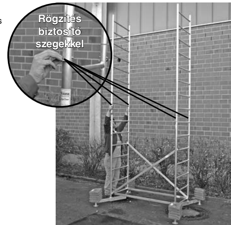
Alapállvány első és második magasítással
