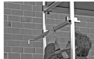
Grunnstillas med første og andre tilbygget
