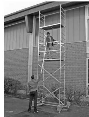
Grundmodul med første og anden tilbygning
