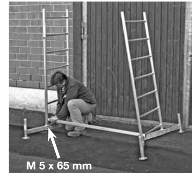
Perustelineet yhdellä lisäkerroksella
