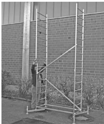
Základné lešenie s prvou nadstavbou
