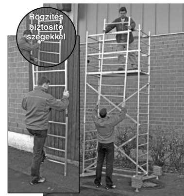
Alapállvány első és második magasítással
