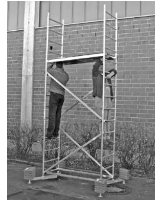
Perustelineet kahdella lisäkerroksella
