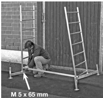
Podstawa rusztowania z pierwszą kondygnacją.
