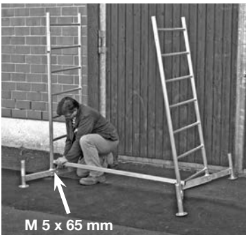
Základné lešenie s prvou nadstavbou
