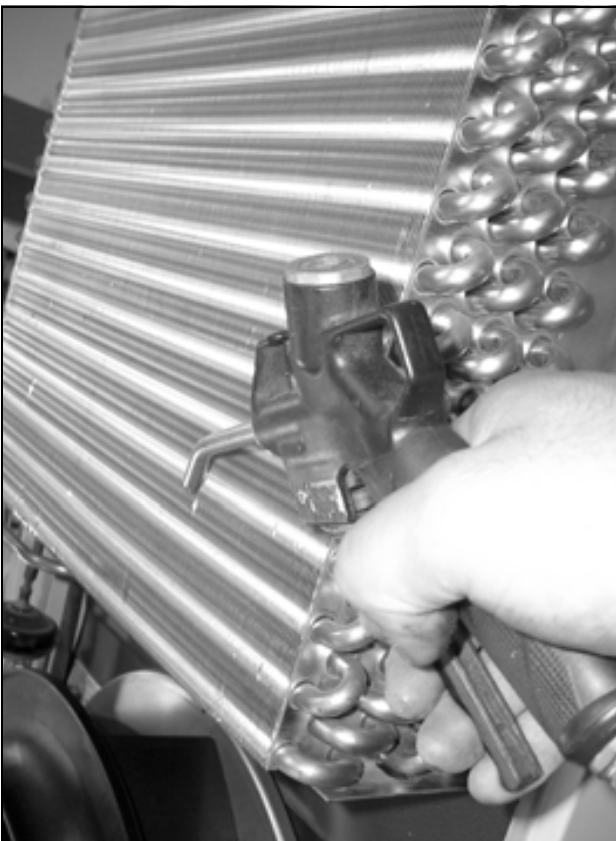
Fig. 75: Limpar os tubos do trocador de calor e o compartimento do compressor com ar comprimido (2)
