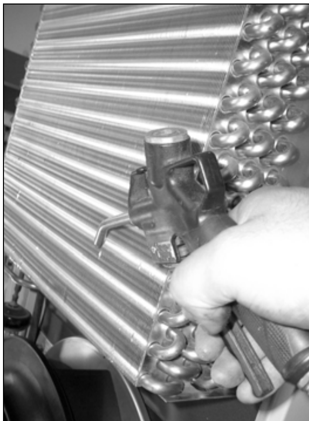
Fig. 51: Limpar os tubos do trocador de calor e o compartimento do compressor com ar comprimido (1)
