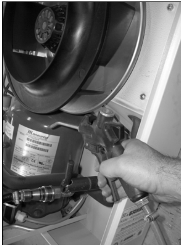
Afb. 52: Warmtewisselaarregister en compressoruimte met perslucht doorblazen (2)
