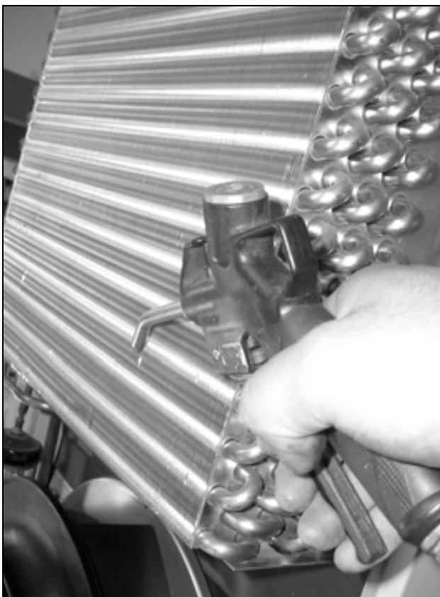
Afb. 51: Warmtewisselaarregister en compressoruimte met perslucht doorblazen (1)
