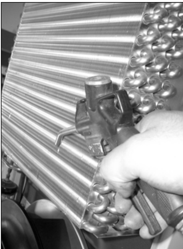
Rys. 51: Przedmuchiwanie sprężonym powietrzem rejestru wymiany ciepła i pomieszczenia kompresora (1)
