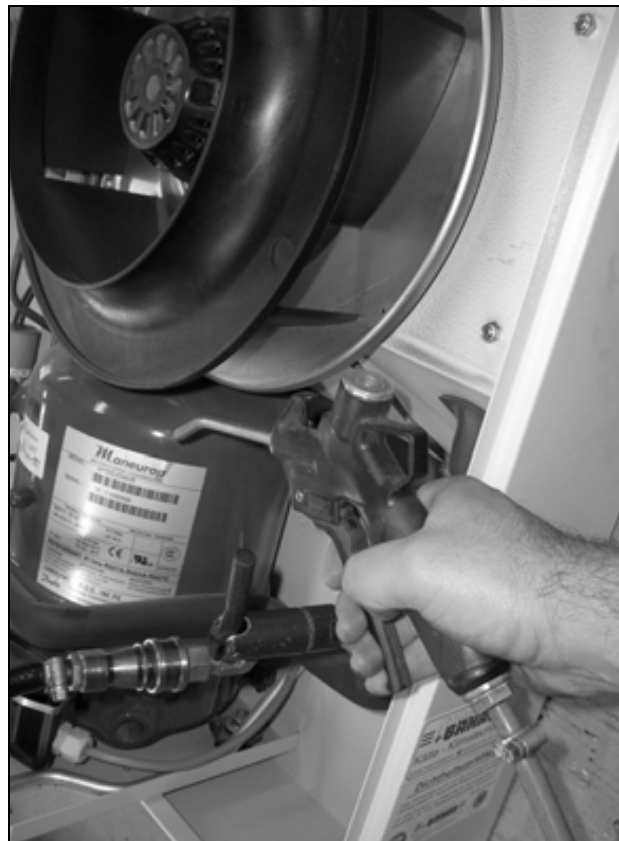
Rys. 52: Przedmuchiwanie sprężonym powietrzem rejestru wymiany ciepła i pomieszczenia kompresora (2)
