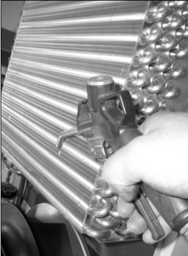
Rys. 75: Przedmuchiwanie sprężonym powietrzem rejestru wymiany ciepła i pomieszczenia kompresora (2)
