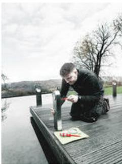
Warum sieht man eigentlich so oft Edelstahlelemente mit Rostbefall? Ein Grund: Häufig wird mit Werkzeug aus „normalem“ Stahl verschraubt, das Fremdrost erzeugen kann. Das ist ärgerlich. Wir waren überzeugt, dass man das verhindern kann. Durch Schraubwerkzeuge, die ebenfalls aus Edelstahl sind und die notwendige Industriestandard-Härte haben. Fremdrostbefall wird verhindert, eine spezielle Vakuummeishärtung sorgt für die notwendige Härte. In VDE-Ausführung.
