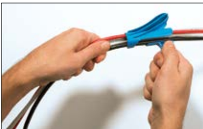
Kabelbündel seitlich in das Aufziehwerkzeug legen.
