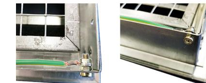
3. MLZ mit dem Einbaurahmen in den Wanddurchbruch schieben und mit 4 Schrauben an der Wand festschrauben.
