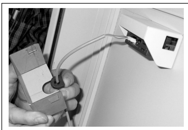
Fig. 14 : Insérer le joint passe-câble
