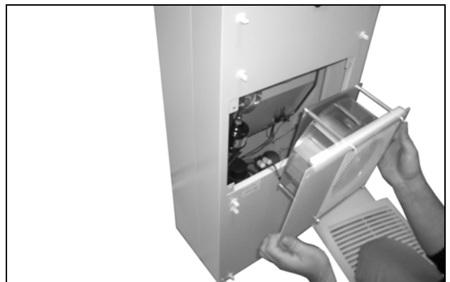
Bild 64: Demontera ytterkretsens fläkt
