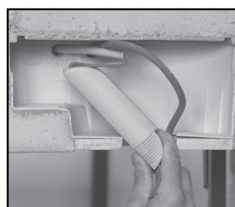
**5.** Einsatz elektronischer Sicherheitstransformators bis max. 150W (z.B. Osram Halotronic HTM Mouse). Sicherheitstransformator anschließen und in das Gehäuse Einbauhöhe 130 mm einschieben. Sekundärseitig wärmebeständige Anschlussleitung verwenden (z.B. N2GMH 2G).
