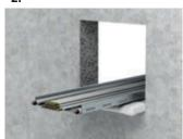
Brandschutzkissen waagerecht/ längs in die Öffnung einbringen. Mindestens eine Kissenlage sollte unter durchgeführten Kabeltrassen platziert werden.
