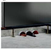
Restliche Öffnung mit Brandschutzmörtel PYRO-SAFE® NOVASIT BM. Schottdicke ≥ 150 mm verschließen.
