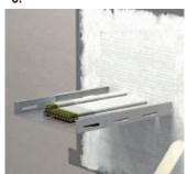
Die Oberfläche der Abschottung mit FLAMRO® BMA beschichten (TSD  $\geq$  1 mm). Um hindurchgeführte Installationen ist ein mindestens 30 mm breiter Streifen so zu beschichten, dass die TSD  $\geq$  2 mm beträgt.
