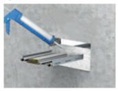
Brandschutzschaum schichtweise vollständig in die Öffnung einbringen und alle Zwischenräume ausfüllen.
