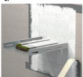
Die Oberfläche der Abschottung mit FLAMRO® BMA beschichten (TSD ≥ 1 mm). Um hindurchgeführte Installationen ist ein mind. 30 mm breiter Streifen so zu beschichten, dass die TSD ≥ 2 mm beträgt.
