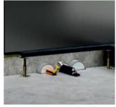
Stopfen komplett mit PYRO-SAFE® FLAMMOTECT-A versiegeln (TSD ≥ 1 mm).
