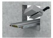
Brandschutzstein entsprechend der durchgeführten Medien passend zuschneiden.
