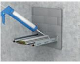
Restspalte und Fugen mit PYRO-SAFE® DG-SC oder FLAMRO® BSS verschließen.
