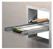
Bauteillaibung reinigen und mit FLAMRO<sup>®</sup> BMA beschichten (TSD ≥ 2 mm).
