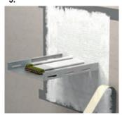
Die Oberfläche der Abschottung mit FLAMRO® BMA beschichten (TSD ≥ 1 mm). Um hindurchgeführte Installationen ist ein ca. 30 mm breiter Streifen so zu beschichten, dass die TSD ≥ 1,5 mm beträgt.
