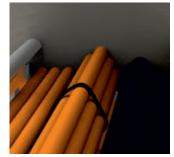
Brandschutzmasse hohlraumfrei so in die Öffnung einbringen, dass ein fester, dichter Anschluss zum Bauteil entsteht. Zwischenräume und Zwickel dabei vollständig ausfüllen.
