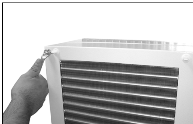
Obr. 44: Demontáž krytu (uvolnění čtyř matic)
