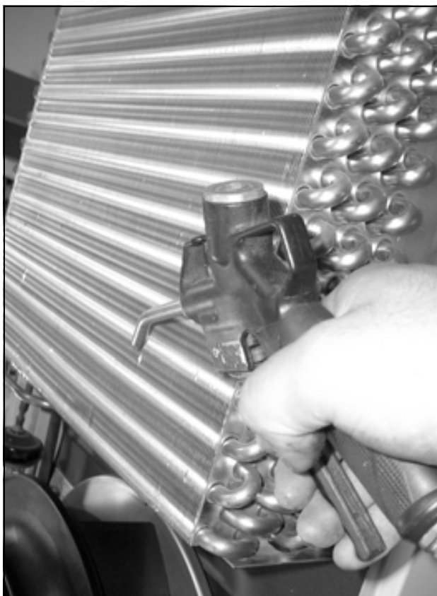
Obr. 75: Vyfoukání žebér výměníku tepla a prostoru kompresoru stlačeným vzduchem (2)
