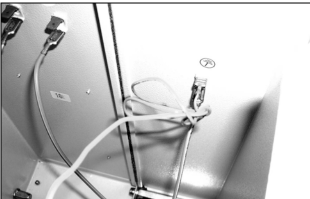
Obr. 68: Odpojení uzemňovacího kabelu ventilátoru (1)
