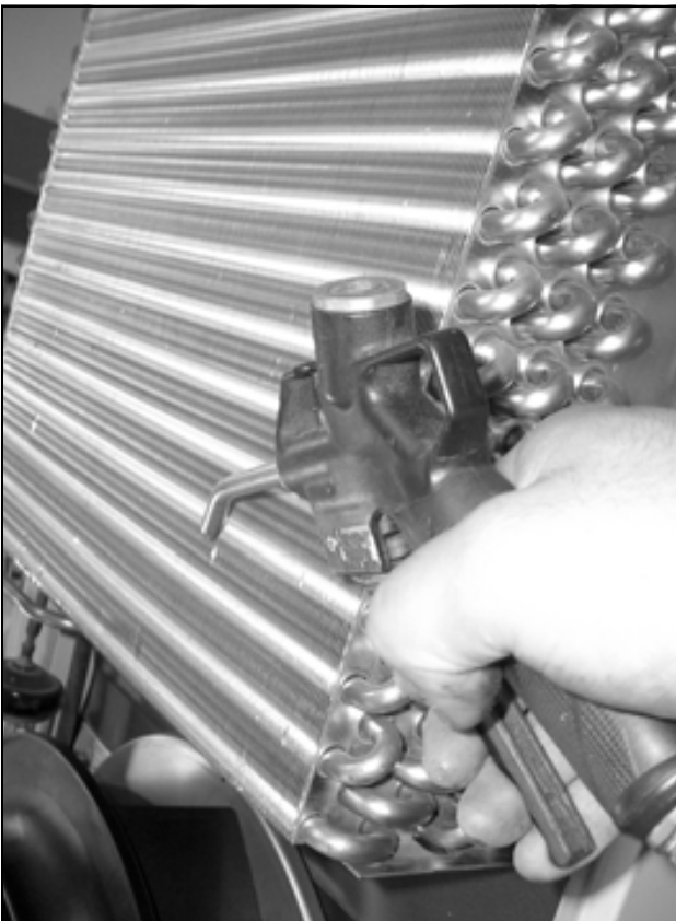
Imagen 51: Aplicar aire a presión en el registro del intercambiador de calor y el espacio del compresor (1)
