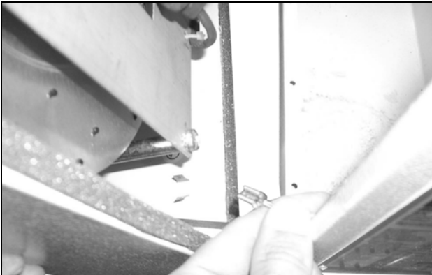
Imagen 50: Desconectar el cable de puesta a tierra entre la cubierta y el chasis (2)
