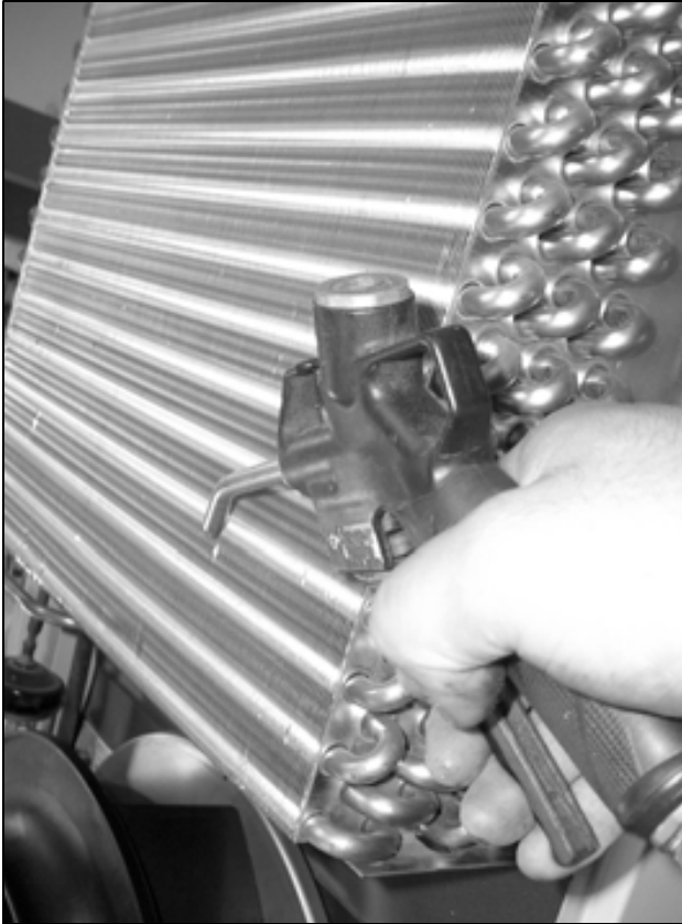
Imagen 75: Aplicar aire a presión en el registro del intercambiador de calor y el espacio del compresor (2)
