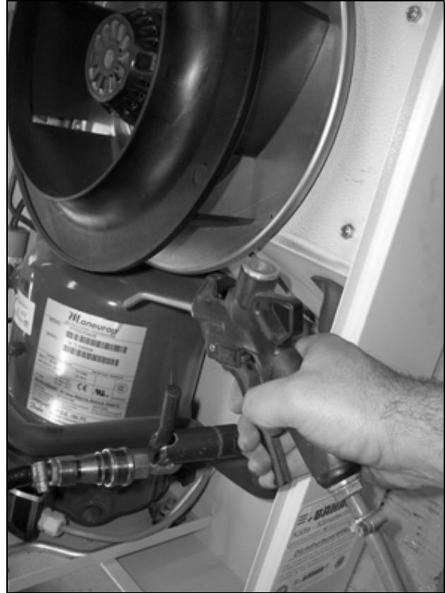
Imagen 52: Aplicar aire a presión en el registro del intercambiador de calor y el espacio del compresor (2)
