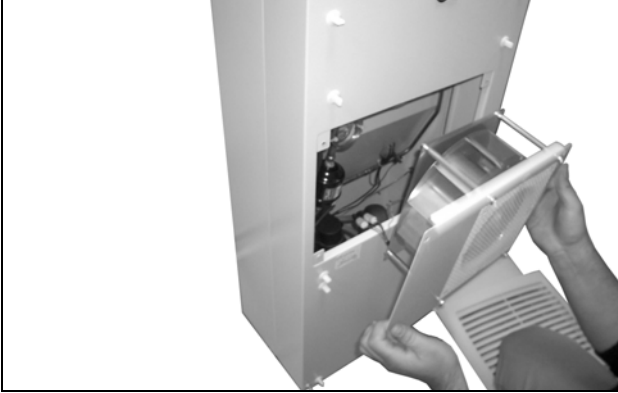
Imagen 64: Desmontar el ventilador del circuito exterior
