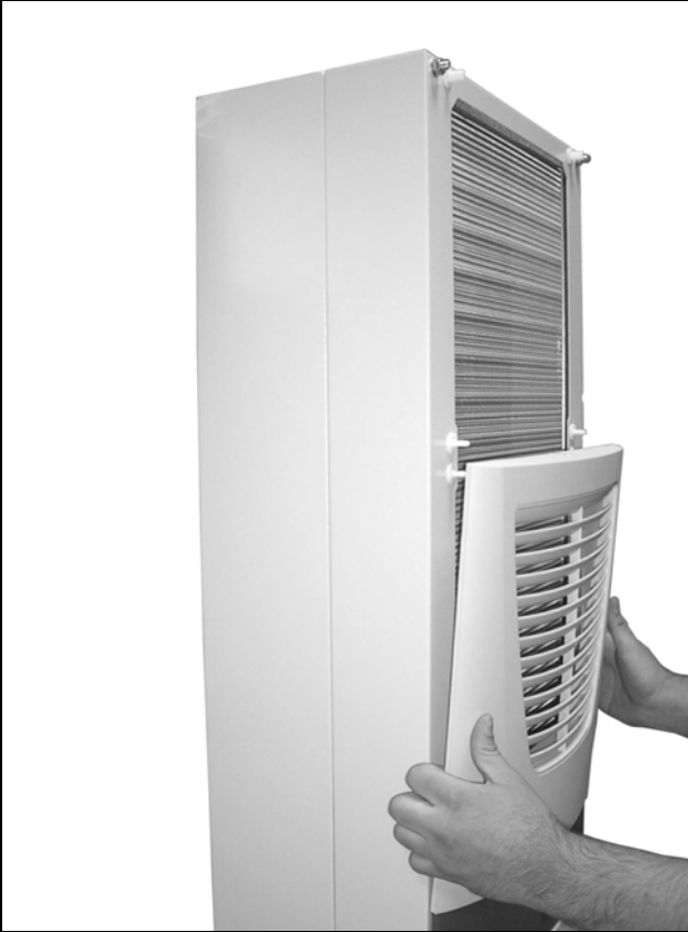
Şek. 56: Üst lamel ızgarasını çıkarın (3)
