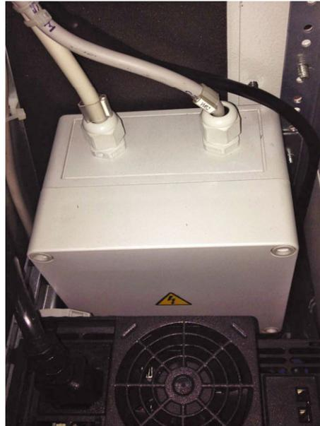
Abb. 52: Zusätzliche Box für die Thermosicherungen der elektrischen Heizer
