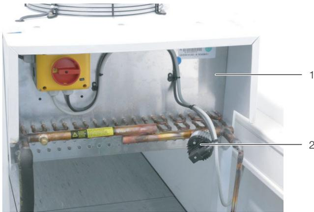
Abb. 27: Druckschalter am Verflüssiger
