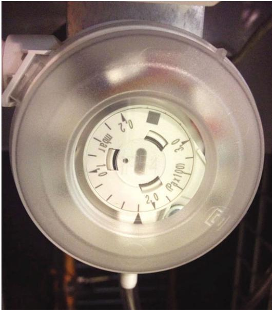
Abb. 57: Einstellschraube am Differenzdrucksensor
