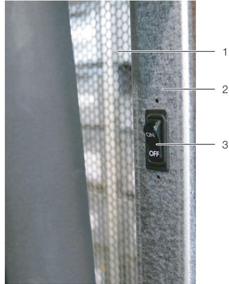
Abb. 42: Schalter zum Ein- und Ausschalten eines Lüfters
