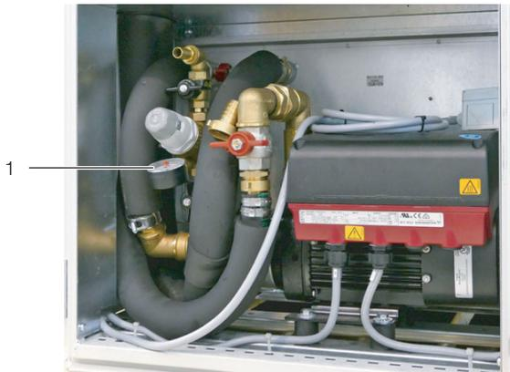
Abb. 44: Manometer im Wasserkreislauf
