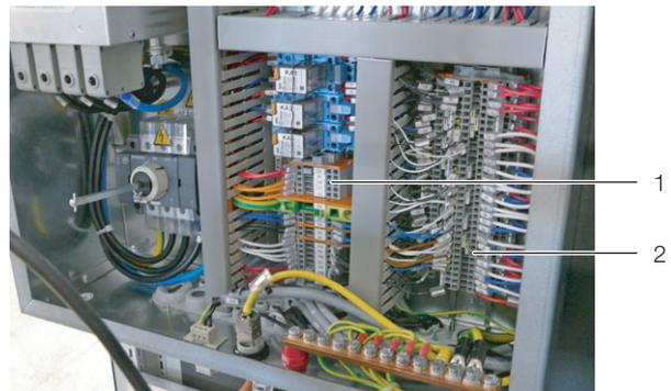
Abb. 31: Klemmleisten X1A und X2A in der Elektronikbox
