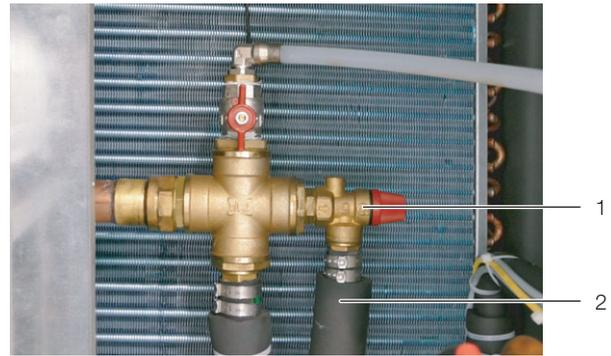
Abb. 24: Sicherheitsventil auf der Rückseite
