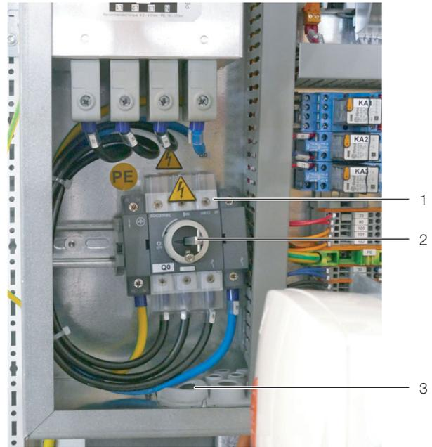
Abb. 25: Geöffnete Elektronikbox
