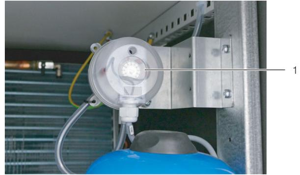
Abb. 60: Einstellschraube am Differenzdrucksensor
