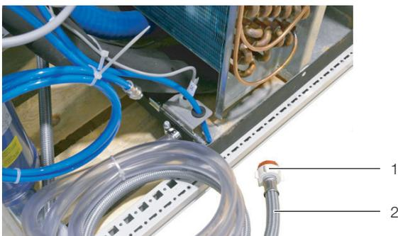
Abb. 50: Anschlusschlauch mit Anschlussstück 3/4" Außengewinde
