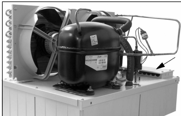
Fig. 29: Condicionador de ar sem tampa (visto de trás)
