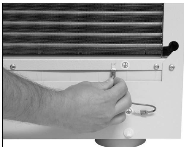
Rys. 25: Wyciąganie kabla uziemienia
