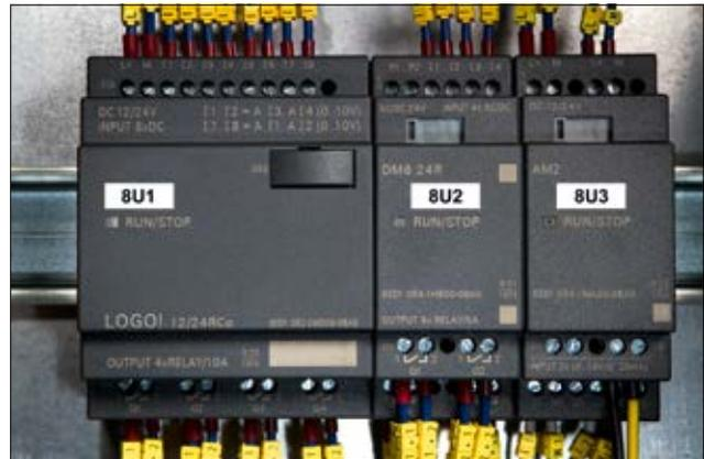
Helatag Laseretiketten ermöglichen die einfache und schnelle Kennzeichnung von Schaltschränken.
